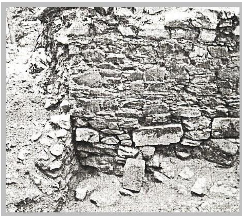
Obrázek 5 Velešín – severní část vnějšího líce západní stěny kaple s druhotně užitými kvádry na fotografii z výzkumu A. Hejny. Vlevo patrné přizdění tohoto líce ke starší zdi (nádvoří stěně paláce) Foto ARÚ ČSAV Praha
