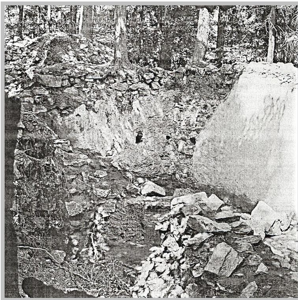
Obrázek č.6 Velešín- severozápadní kout interiéru kaple s dochovanými omítkami, otiskem schodiště a s ním souvisejícími kapsami na snímku z výzkumu A.Hejny v popředí vstup do kaple. Tmavé plochy jsou poškození negativu povodní v roce 2002. Foto ARÚ ČSAV Praha
